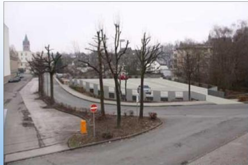
Parkraumergänzung Parkplatz Dr. Eugen-Kersting-Straße
