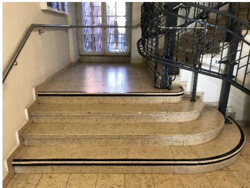
Kontrastreiche Markierung an den Kanten der Stufen im Rathaus
